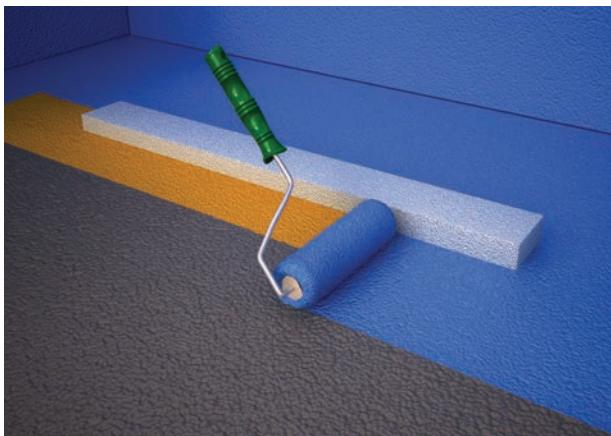
**PT** Aplicar a impermeabilização no pavimento e paredes (2 camadas recomendadas)
