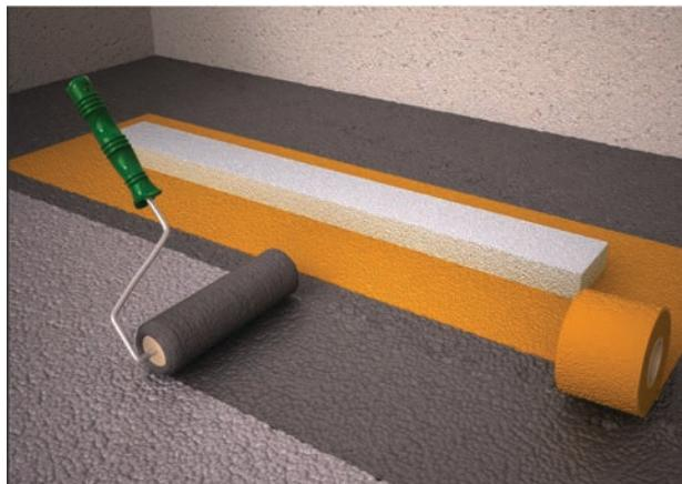
**PT** Limpar o topo da calha removendo lixo e detritos, aplicar bandas impermeabilizantes
